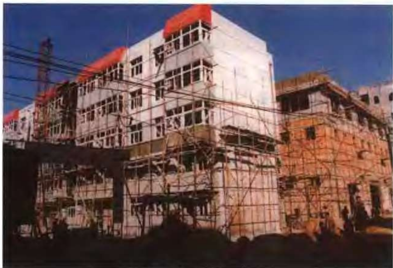
金兴集团施工大楼一角
