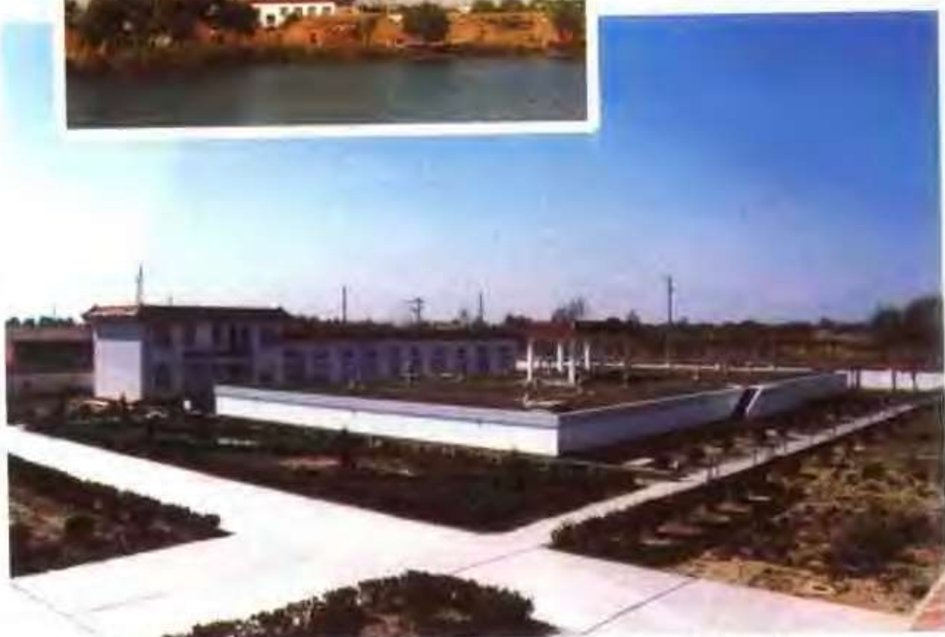
新建供水中心
