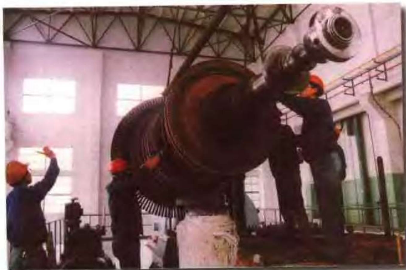
热电厂工人在安装机组
